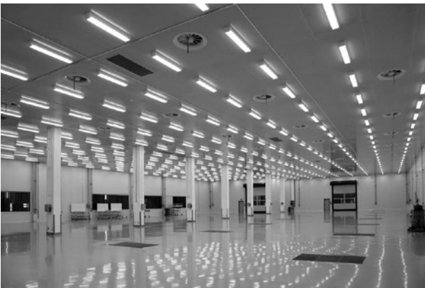
图3 铺叠间室内内景1
